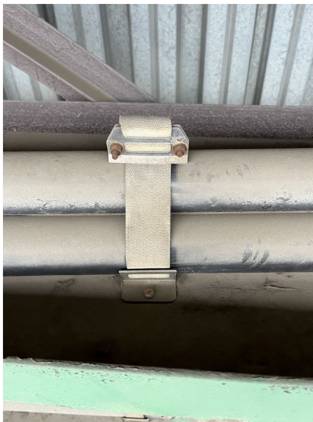
4 – kabely na lávkách připevněný nevyhovujícími textilními pásy
