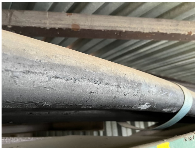
2- kabel s loupající se grafitovou vrstvou
