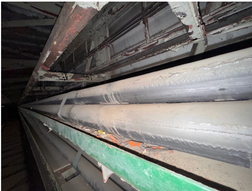
3 – kabely na lávce bez příchytěk
