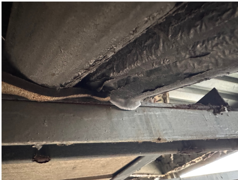
5 - plášťová porucha v místě přechodu z mostu do vertikálního úseku kab. vedení.
