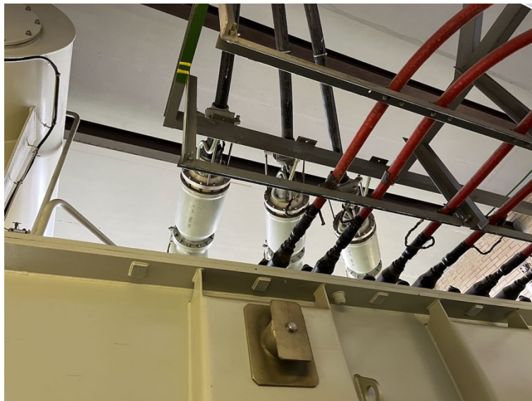
1- kabelové koncovky Sudkabel EHSVS 123 z roku 2001.
